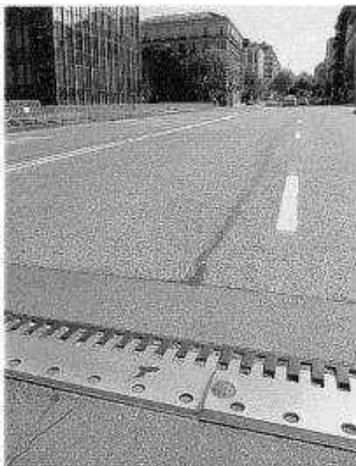
Figura 3. Las juntas de dilatación también se usan en los puentes, con la finalidad de que el concreto ceda cuando se dilate y este no se agriete.
